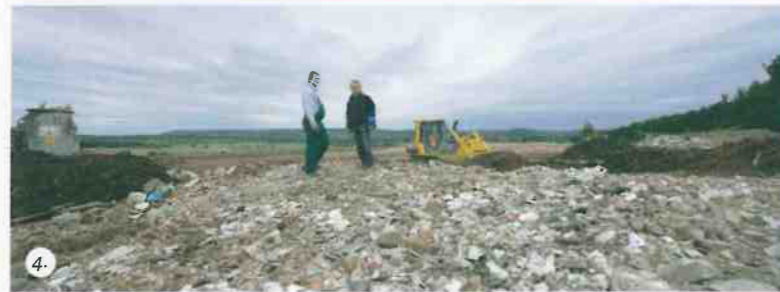
1. Von links nach rechts: Herr Zeller (Enzkreis) und Herr Tschackert (AVL, Landkreis LB), Geschäftsführer der HAMBERG DEPONIE-GESELLSCHAFT mbH 2. Aufbringen der Basisabdichtung zur Vorbereitung einer neuen Einbaufläche 3. Angelieferter Bauschutt im Haufwerk 4. Der Bauschutt wird in die Deponiefläche eingebaut und verdichtet 5. Gasdom in der Einbaufläche
